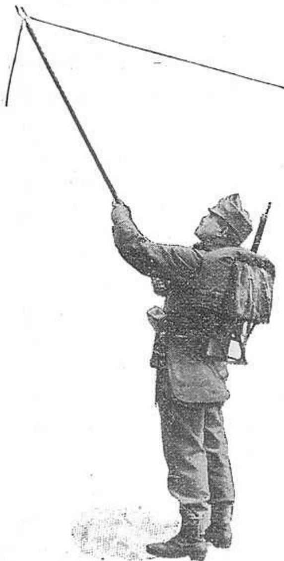
Der Draht ist durch allmähliches Anziehen — und nicht durch Anreißen — zu spannen; nach dem Spannen soll der Draht einen der Spannweite entsprechenden Durchhang haben — also nicht straff angezogen sein.
