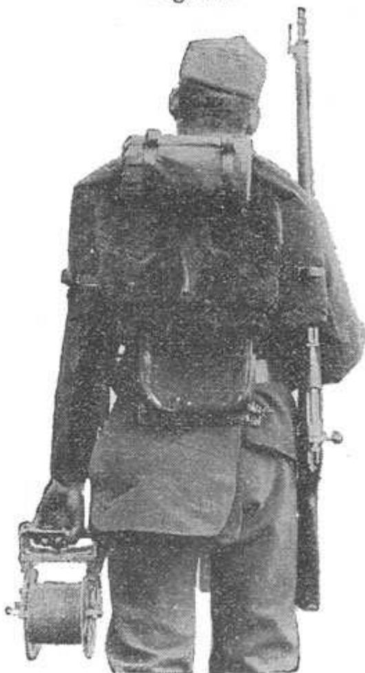
oder Leitungsträger angestellt; dieser Mann geht dann hinter der Nr. 3, läßt den Draht durch die mit einem dicken Tuchlappen oder Lederfleck geschützte Hand gleiten und gibt acht, daß Schlingenbildungen und zu starkes Spannen vermieden werden; hiezu regelt er die Marschgeschwindigkeit der Nr. 3 nach dem Fortschritt der Arbeiten des, beziehungsweise der Hebegabelträger.
